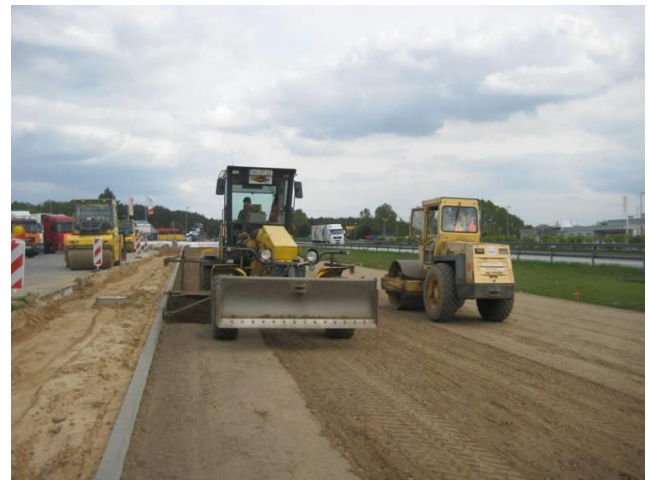
zweilagiger Einbau der ungebundenen Tragschichten am Standort Nord im Mai 2010
