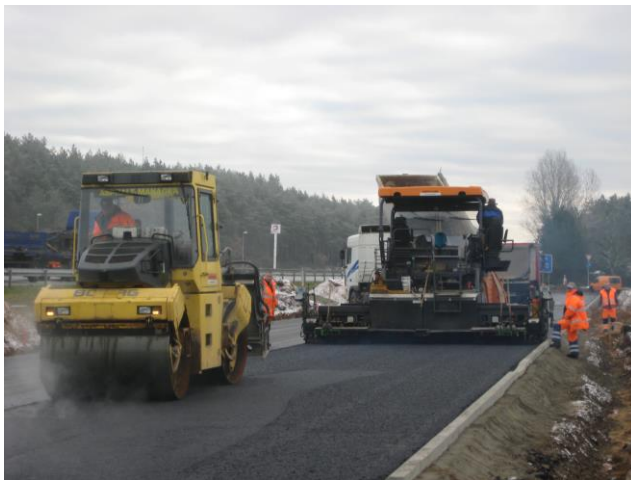
dreilagiger Asphalteinbau der Parallelfahrbahn am Standort Süd im Dezember 2009
