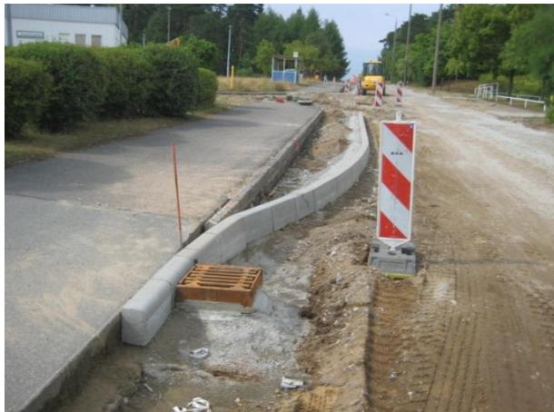
Setzen der neuen Hochbordanlage, die neue Fahrbahn wurde gegenüber dem Altzustand als Hauptzufahrt zu einer ehemaligen Kaserne schmaler gebaut, zwischen dem zu erhaltenen Gehweg und der neuen 6,0 m breiten Fahrbahn wurde ein Grünstreifen angeordnet
