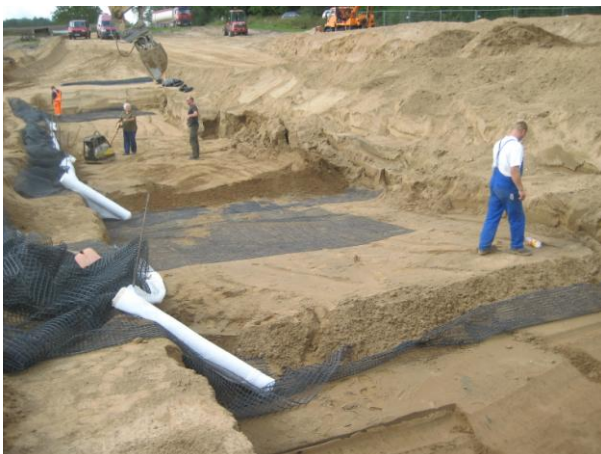
lagenweiser Geogittereinbau zur späteren Einspannung des Straßendamms im torfigen Baugrund
