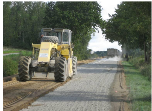
Bodenstabilisierung mittels Einpflügen von Zement in den vorbereiteten Untergrund
