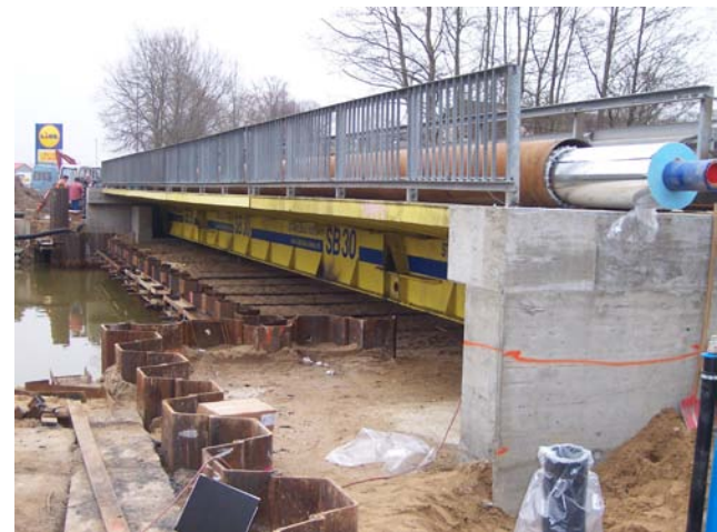
Behelfsbrücke im Bereich der Wehrbrücke mit Leitungsüberführung der Trinkwasser- und Abwasserdruckrohrleitung im Schutzrohr
