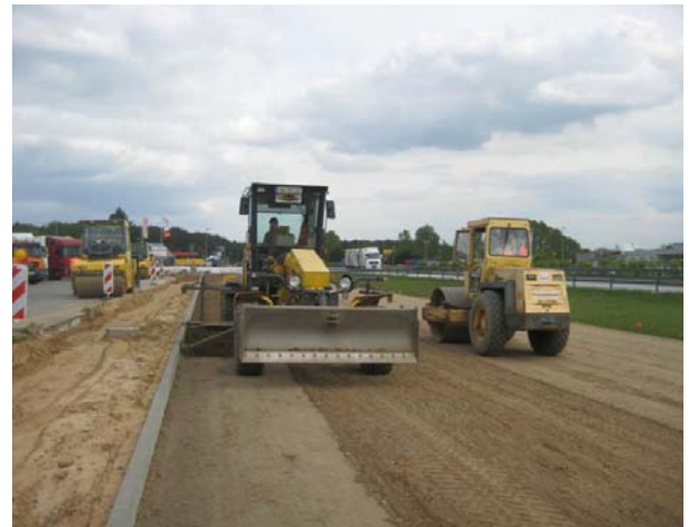
zweilagiger Einbau der ungebundenen Tragschichten am Standort Nord im Mai 2010
