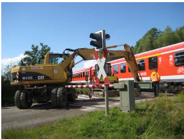
direkte Arbeiten am Bahnübergang erfolgten ohne Einschränkung des Zugverkehrs mittels Koordination eines Bauüberwachers Bahn/Bau
