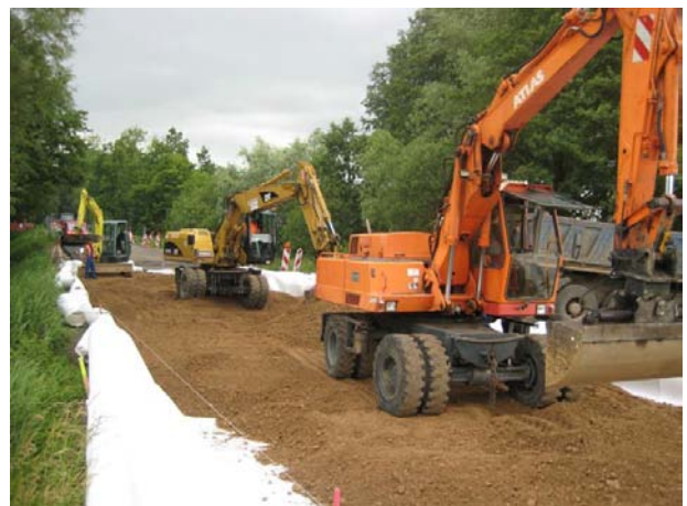
Einbau einer Geogittermatratze aufgrund des schwach tragfähigen Baugrunds unterhalb der Fahrbahn der Bundesstraße
